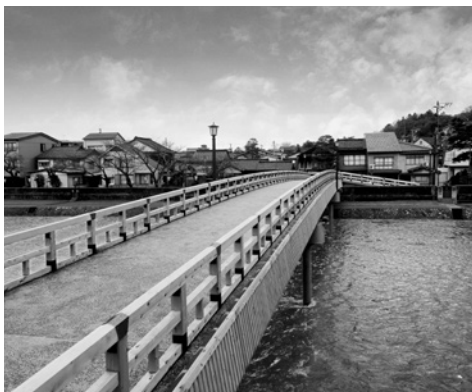
施工実績「梅の橋」。浅野川大橋の上流側に架かるこの橋は、文豪・泉鏡花の作品にも登場する名橋として名高い
