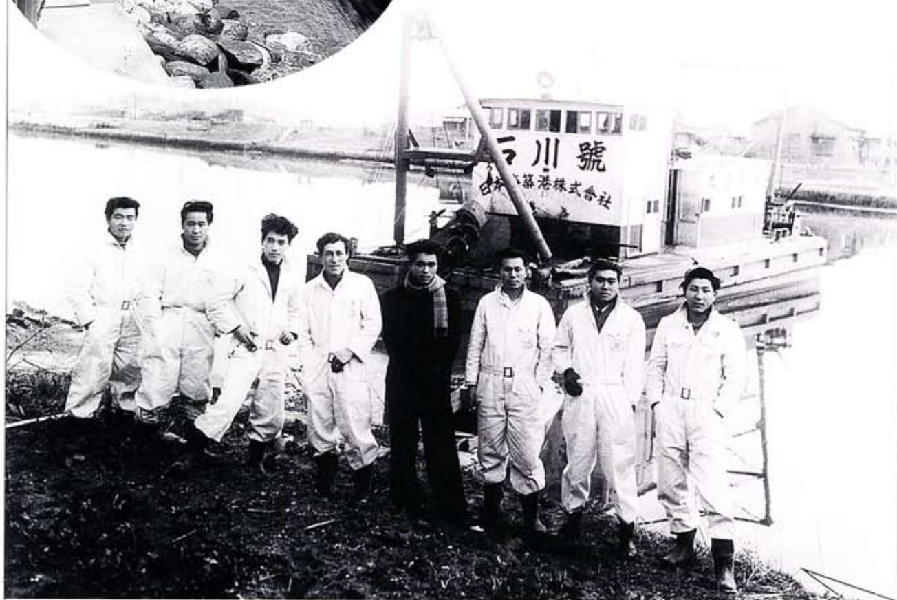
昭和25年4月に、2隻目を購入した木造製のポンプ浚渫船「石川號」。フローターを継管し、ポンプ排泥管を延長し、中継して、金沢市大野川河口を浚渫していた当時の写真。
