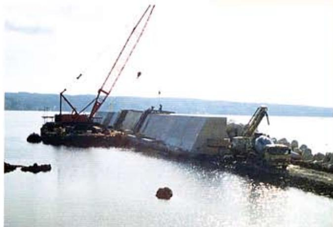
台船上クレーンによる上部工生コン打設状況
